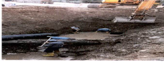
Kanalizasyon Baca Yükseltme Çalışması
