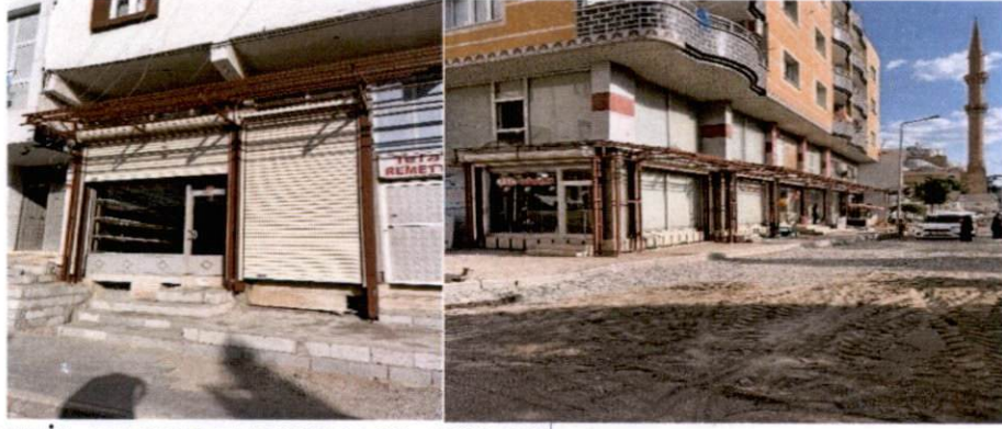
KEPENK VE PROFİL YAPIM ÇALIŞMASI=1200 M2
