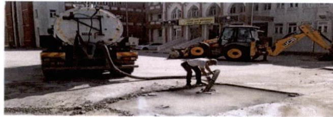
Konak Mahallesi İmam Hatip Lisesi Su Arıza Su Çekme Çalışması
