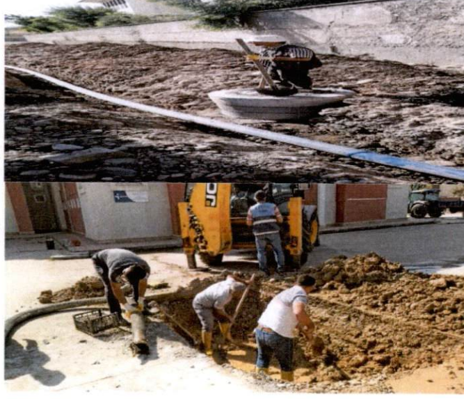
Konak mahallesi Cizre kız Anadolu İmam Hatip lisesi İçme Suyu Patlak Onarım Çalışmaları
