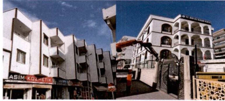
*DIŞ CEPHE BOYA ÇALIŞMASI=8650 M2
