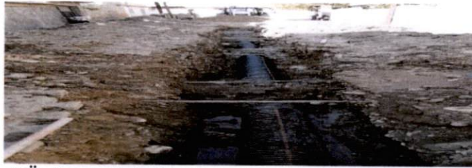
Cudi Mahallesi Özdemir Sokakta Kanalizasyon Yeni Hat Çalışmaları
