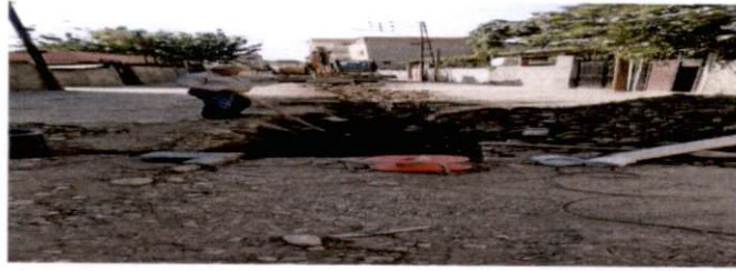
Cudi Mahallesi Özdemir Sokak Kanalizasyon Q300'lük Yeni Hat Döşeme Çalışmaları
