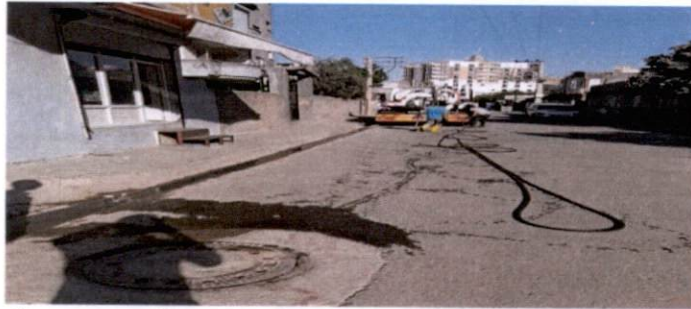
Tıkanan kanalizasyon ve baca temizleme çalışmaları
