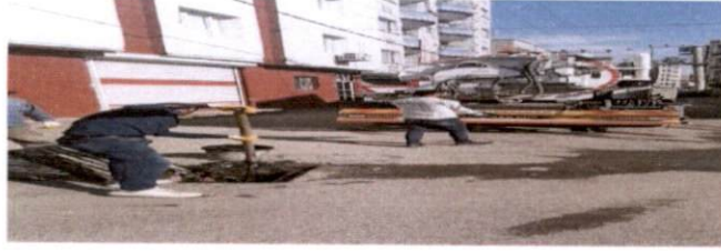
Cudi Mahallesi Sitti Hayat Caddesi Yağmurlama Temizleme Çalışmaları
