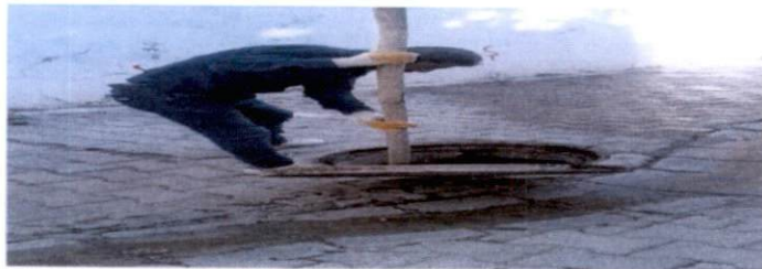
Yafes Mahallesi Cam Sokak Kanalizasyon ve Baca Temizleme Çalışması
