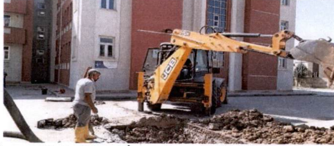
Cizre Anadolu İmam Hatip Lisesi İçme Suyu Patlak Onarım Çalışmaları
