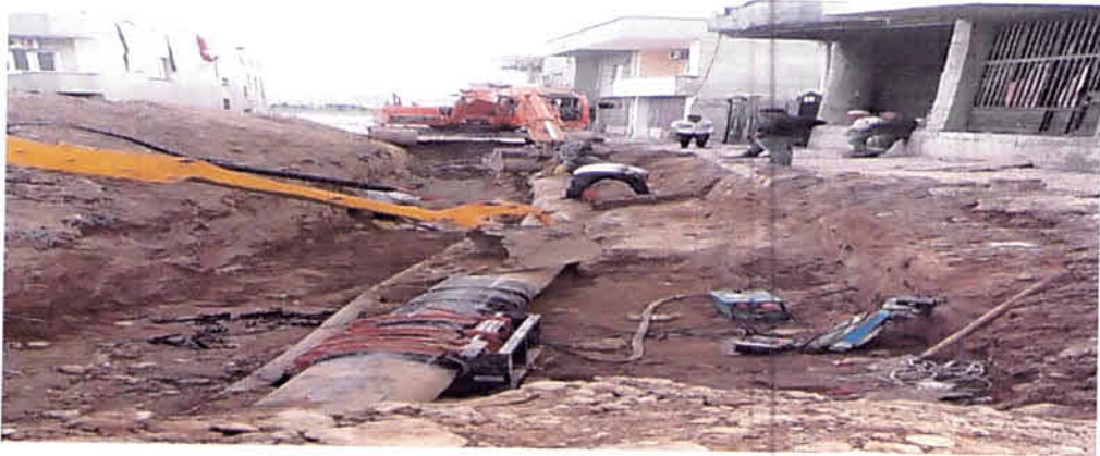
Q 450'lik Polietilen Boru Alın Kaynak Çalışması
