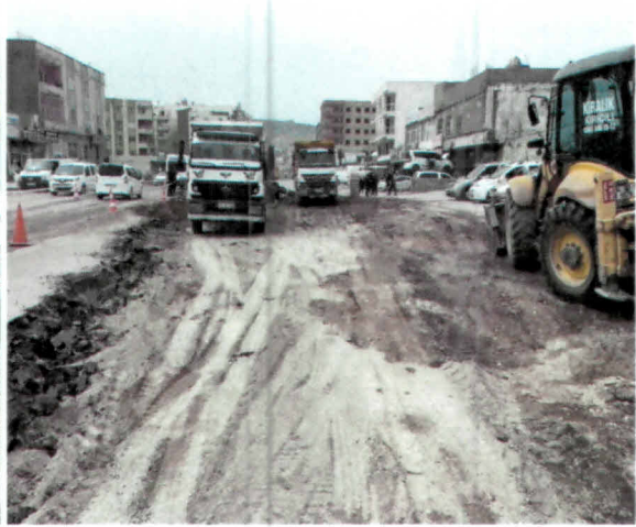
25) İlçemiz Yafes Caddesi Asfalt Söküm Çalışması =5233,19 m 3
